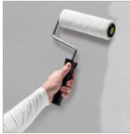
Aplicați stratul de bază **Jeger Primer Beton** pe un perete uscat, fără praf și fără grăsimi (conform instrucțiunilor de pe ambalaj) și lăsați să se usuce timp de aproximativ 4 ore.
